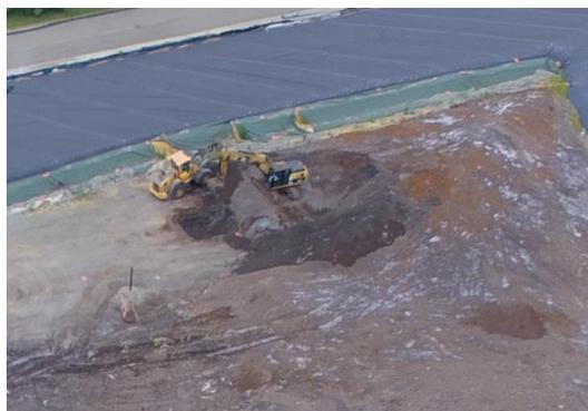
**Fig. 5 - Scarico e movimentazione rifiuti**
