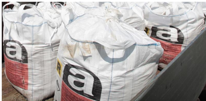
Fig. 3- Rifiuti contenenti amianto confezionati in big-bag.
