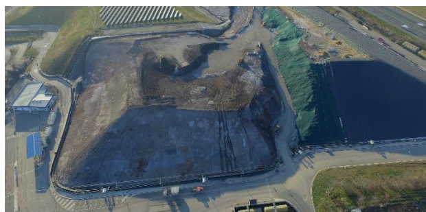
Fig. 5 – Scarico e movimentazione rifiuti
