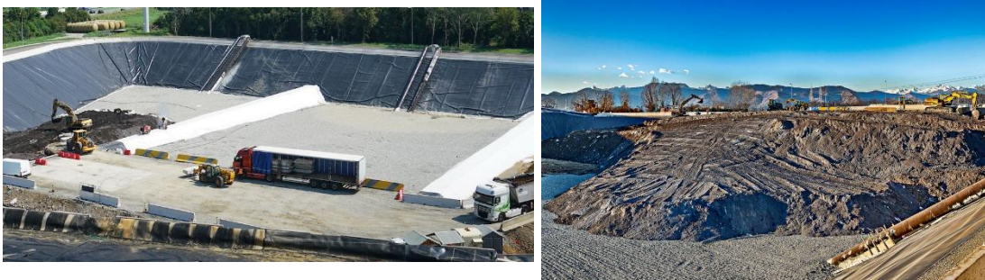
Fig. 5 – Scarico e movimentazione rifiuti
