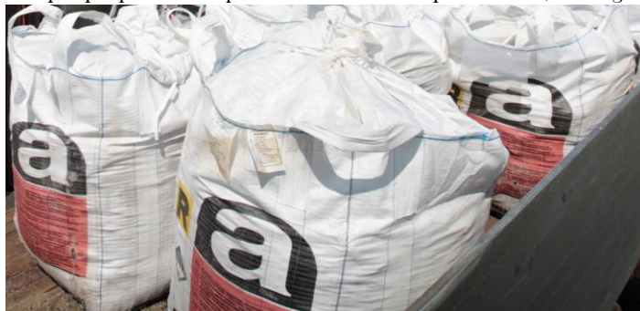
Fig. 3- Rifiuti contenenti amianto confezionati in big-bags.
