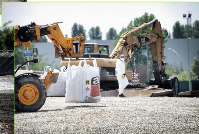
Fig. 5 – Scarico rifiuti sfusi e movimentazione di big-bags.
