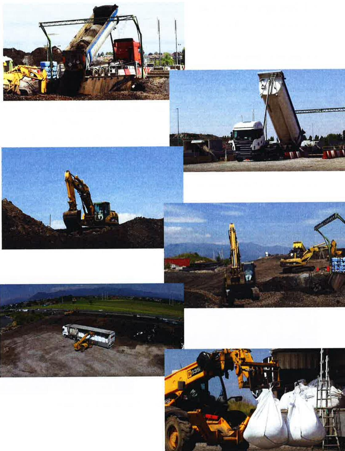
Fig. 5 – Scarico rifiuti sfusi e movimentazione di big-bag.
