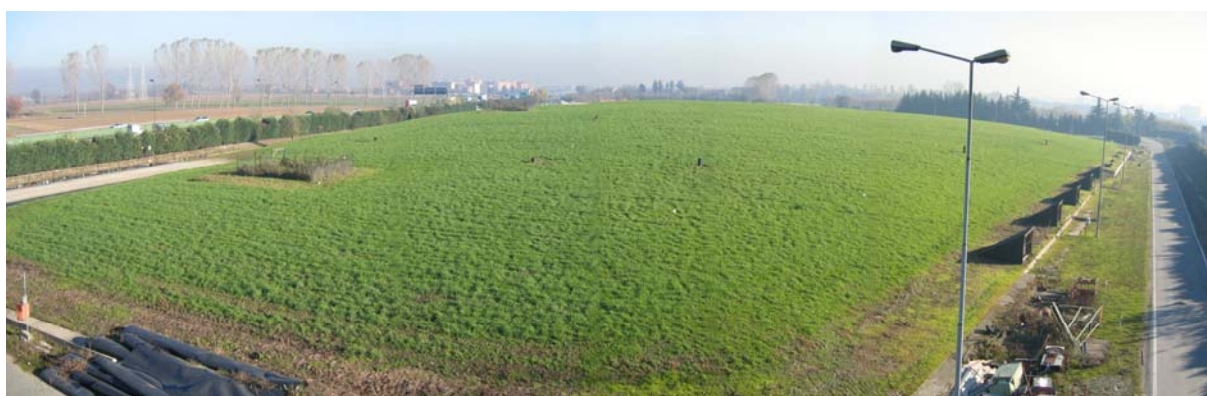
Figura 2 – Vista dell'impianto lato Ovest
